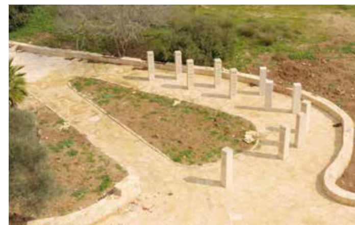
Stenmurar och stenbeläggning har lagts kring pelarna med plaketter.
